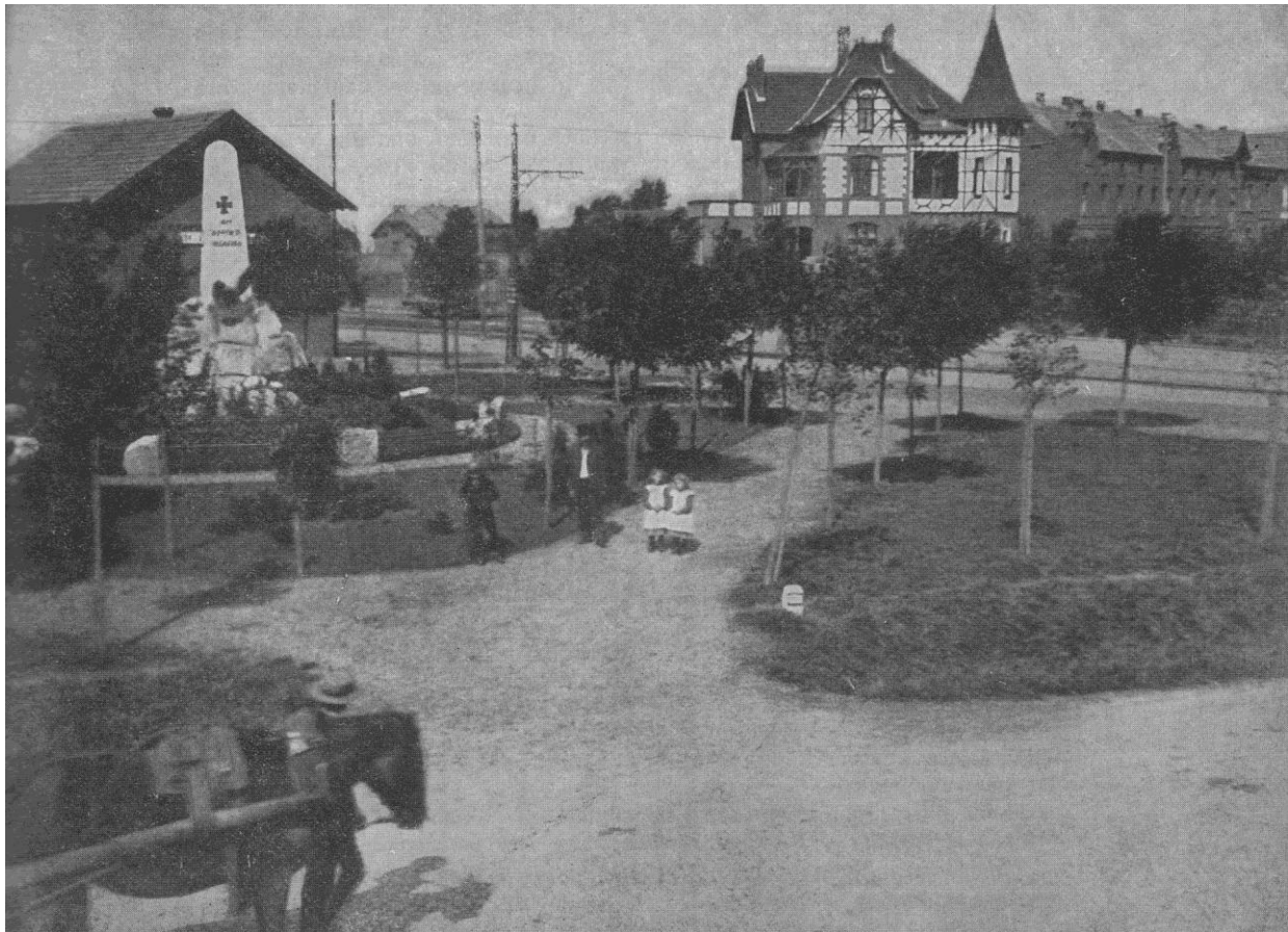
Der Denkmalplatz im Jahre 1905 Links die Bahnhofswirtschaft der Geilenkirchener Kreisbahn, im Hintergrund das heutige Posthotel
